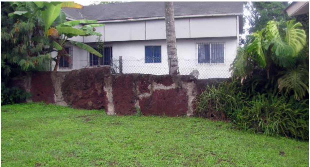
FIG. 86 MURO PERIMETRAL DEL TERRENO DE LA IGLESIA CONSTRUIDO CON GRANDES BLOQUES DE PIEDRA ROJA TALLADA.
